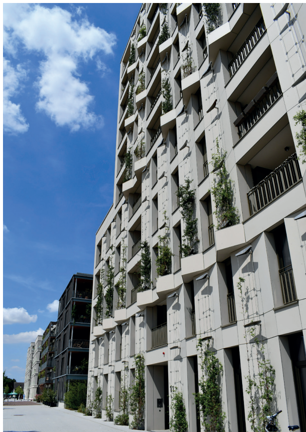
Abb. 13: Wandgebundene Fassadenbegrünung in Regalbauweise (horizontal). Quelle: BuGG
